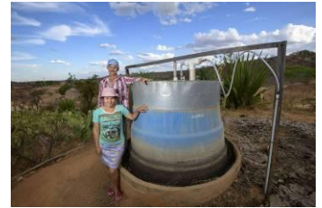
Cleverer Lösung Mit der ausgeklügelten Biogasanlage auf ihrem Anwesen kann Familie Braz Souza Kuhdung in Energie verwandeln, die ihr Haus mit Strom und warmem Wasser versorgt.
