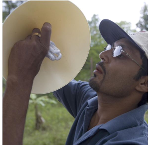
Elektriker Wasanthe vom Projektpartner ASPIRA in Sri Lanka, montiert eine Energiesparbirne in eine Straßenlampe. Foto: Paul Hahn
